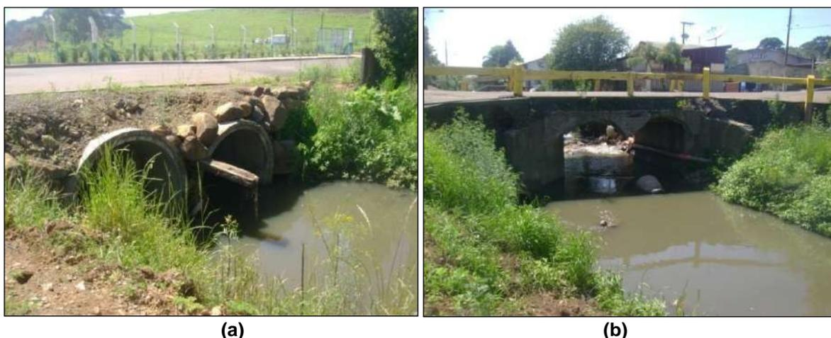
**Figura 143: (a) Aspecto da ponte com tubulações (Rua Bolívia com Rua Equador; (b) Ponte após a remoção dos tubos (Rua Bolívia com Rua Uruguai). (Fotos: Outubro 2011).**
