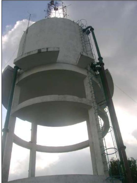
**Figura 52: Reservatório Elevado Utilizado na Limpeza dos Filtros.**
