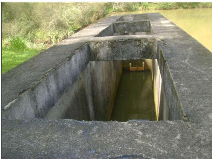
**Figura 35: Canal de Tomada de Água Bruta.**
