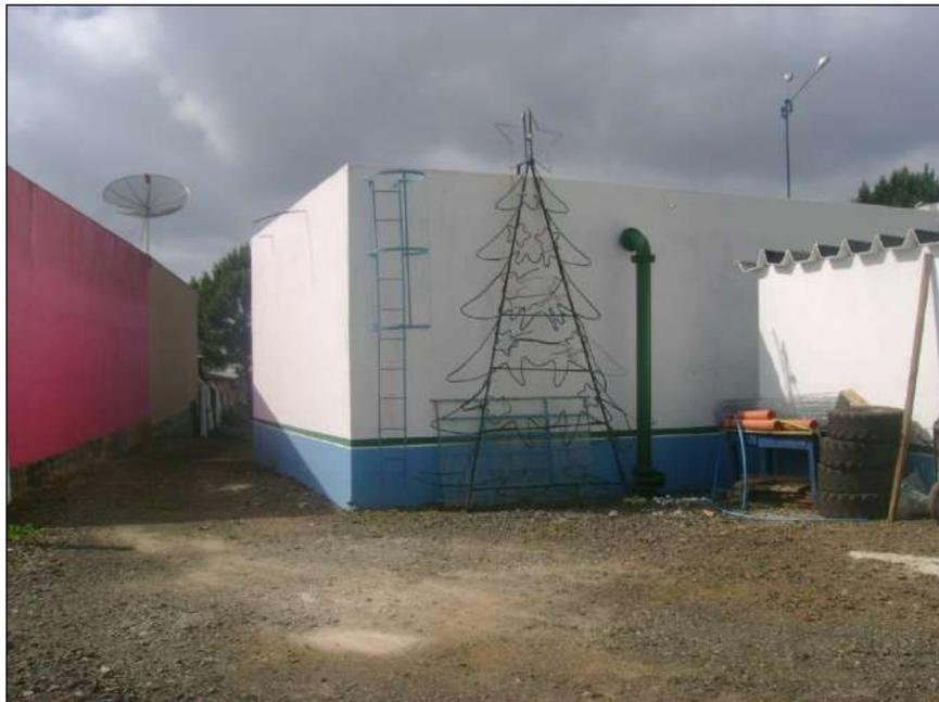
**Figura 60: Reservatório Apoiado Retangular.**
