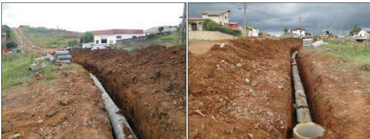
**Figura 138: Execução de Rede Pluvial no Bairro Nações.**
