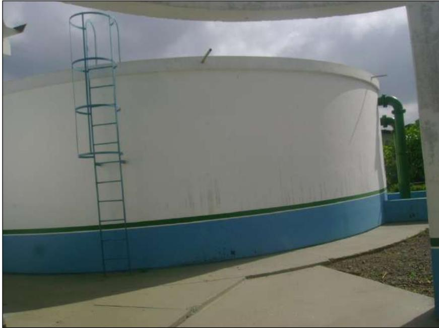
**Figura 59: Reservatório Apoiado Circular.**
