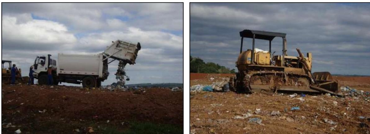
**Figura 90: Descarregamento e Compactação dos Resíduos (Foto: Arquivo SANEFRAI).**
