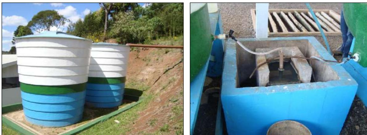
**Figura 93: Vista do Tanque de Equalização e Misturador do Coagulante (Foto: Novembro/2011).**
