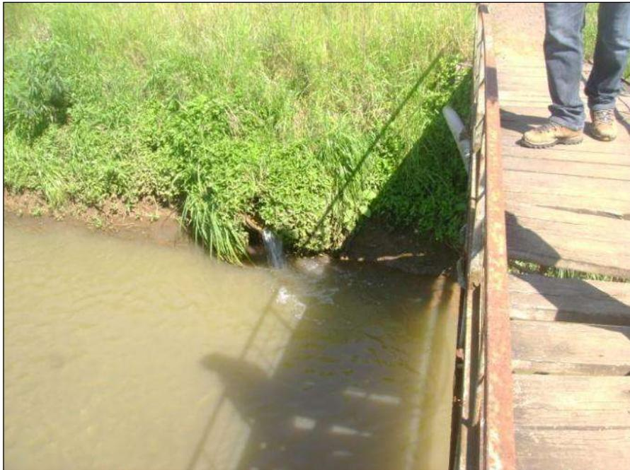
**Figura 151: Exemplo de Drenagem Secundária com Indicativo de Lançamento de Esgoto Doméstico In Natura – Sem Tratamento.
