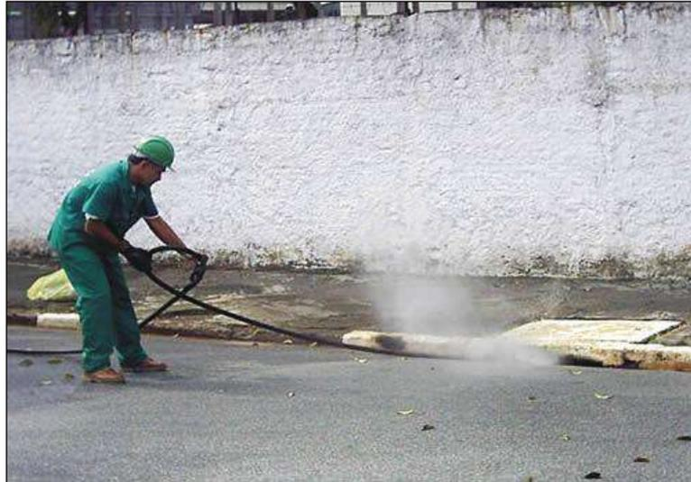
**Figura 137: Exemplo da Utilização do Hidrojateamento no Desentupimento de uma Boca-de-Lobo.**
