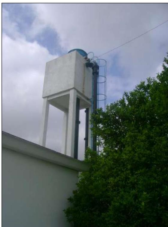
**Figura 51: Caixa de Chegada da Água Bruta.**
